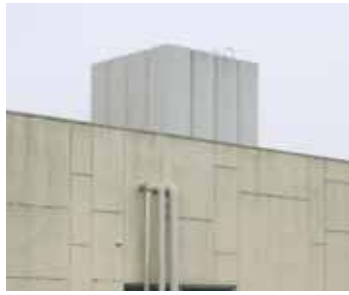
屋上の給水タンク
