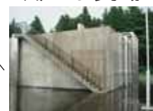
あに 安居配水池
