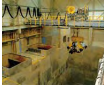
ごみピット、ごみクレーン ごみピットにためられた ごみを、ごみクレーンで つかみ、ごみ投入ホッパへ 投入します。
