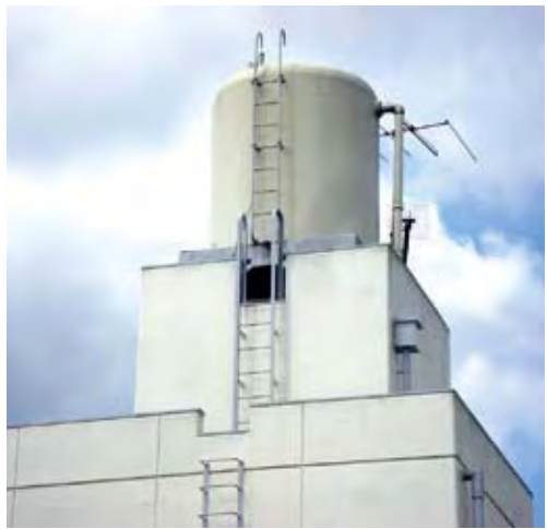
屋上の給水タンク
