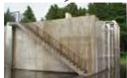
あご 安居配水池(安居)
