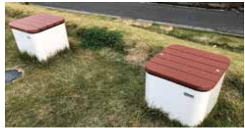
災害のときにトイレになるベンチ
