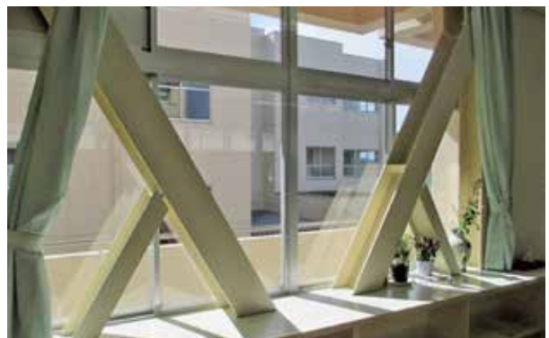
※耐震補強のための筋交い すじか
